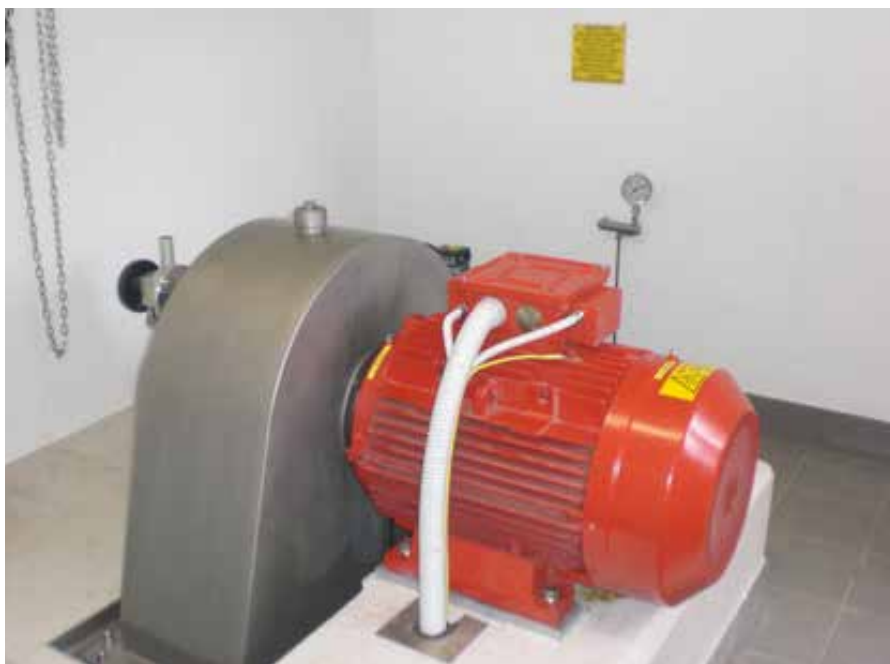
Realizzazione di un impianto idroelettrico presso il serbatoio acqua potabile "Herrenböden"
