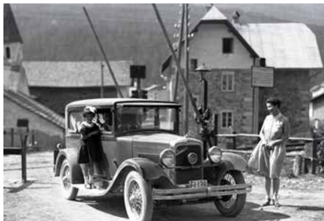
Alter Bahnübergang beim Außerkirchl (ca. 1940) Vecchio passaggio a livello Cappella di Altötting
