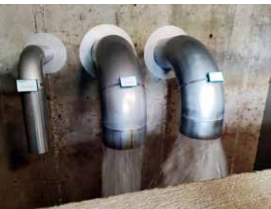
Errichtung eines Trinkwasserkraftwerkes am Speicher „Herrenböden“
