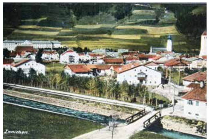
Zimmerer-Brücke, Wasserpromenade und Beginn der Sextner Straße Ponte Zimmerer, passeggiata lungo il Rio Sesto e inizio della Via Sesto
