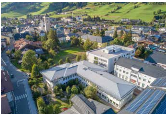
Im Kindergartengebäude wird eine Kindertagesstätte (KITA) errichtet
